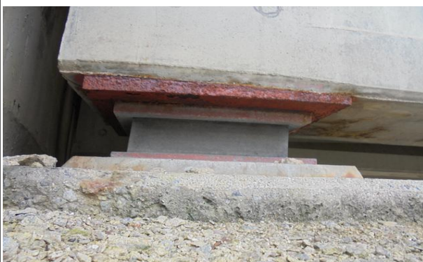
교량 받침 전경
