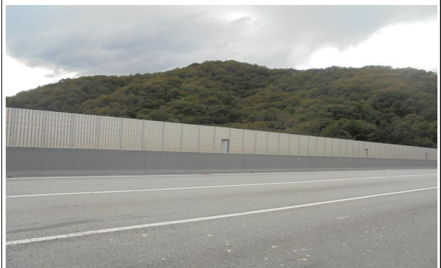
난간 및 연석 전경
